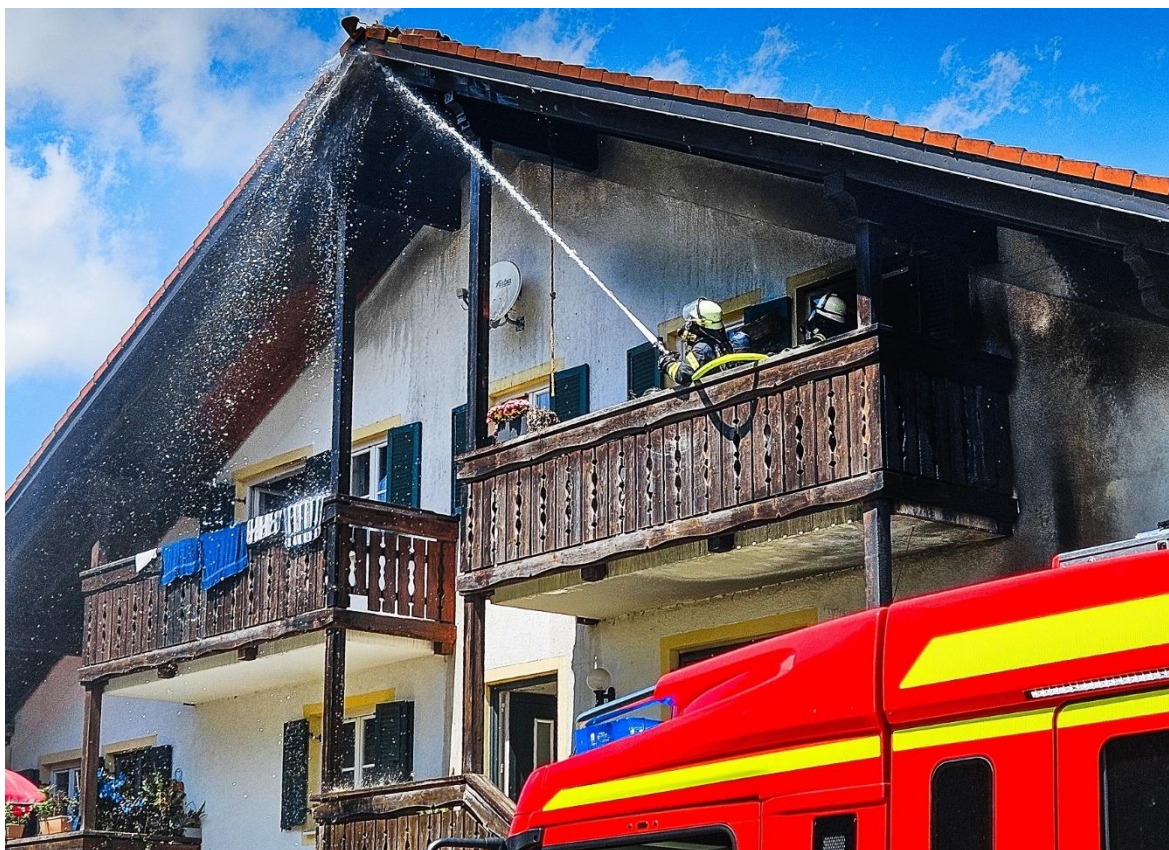
Beim Brand eines Balkons auf einem landwirtschaftlichen Anwesen im Gemeindebereich Karlsfeld konnte durch das schnelle Eingreifen der Feuerwehr eine Ausbreitung verhindert werden – 14.07.2024
