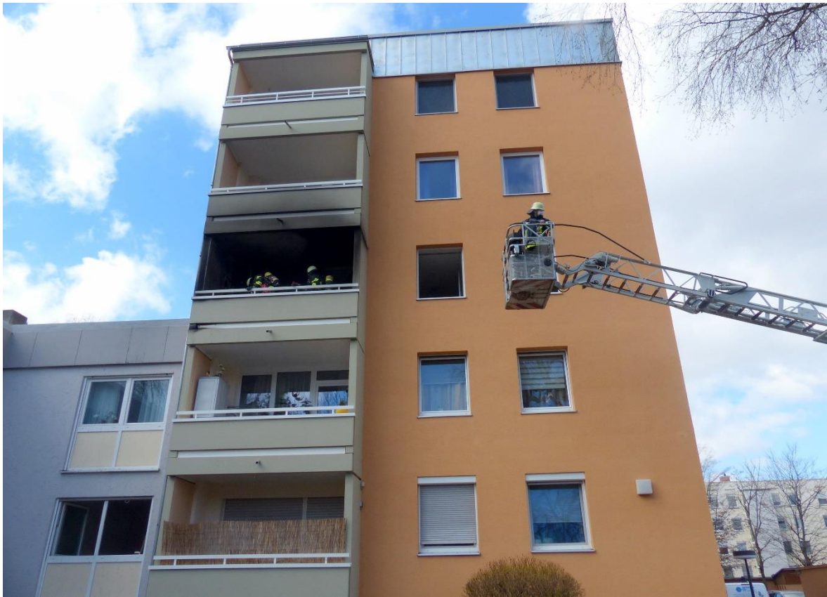
Bei einem Balkonbrand in Dachau konnten glücklicherweise alle Bewohner das Gebäude unbeschadet verlassen – 27.02.2022
