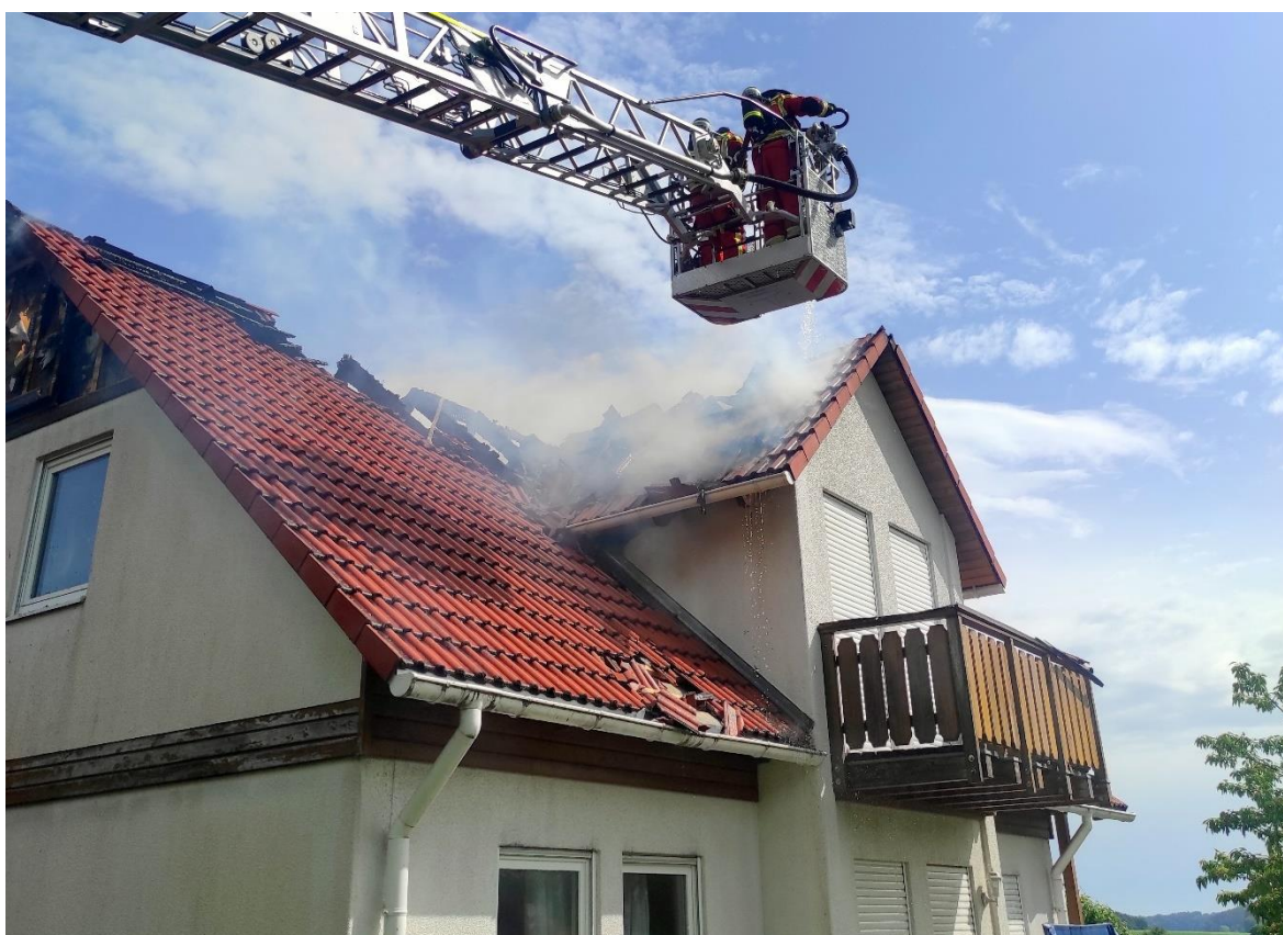
Bei einem Dachstuhlbrand in Pipinsried infolge eines Blitzeinschlags waren rund 80 Feuerwehrkräfte über 6 Stunden im Einsatz – 23.05.2022
