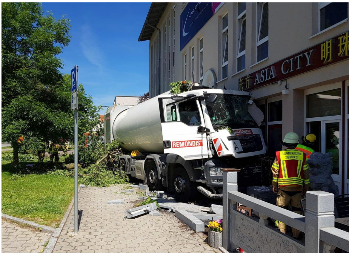
Bei einem Verkehrsunfall auf der Karlsfelder Münchner Straße krachte ein Müllfahrzeug in die Fassade eines Restaurants – 15.06.2021
