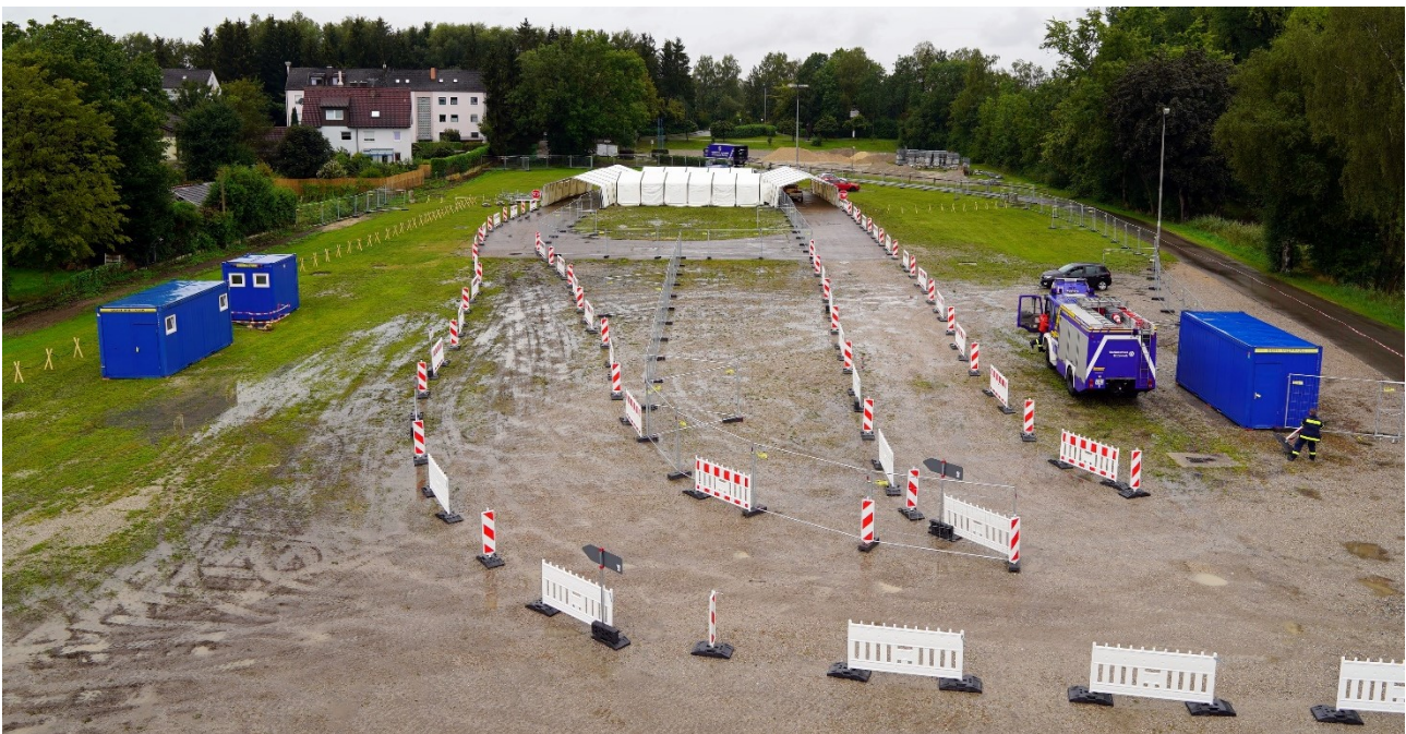
Wiederaufbau der Corona-Teststation in Markt Indersdorf Indersdorf – 29.08.2020
