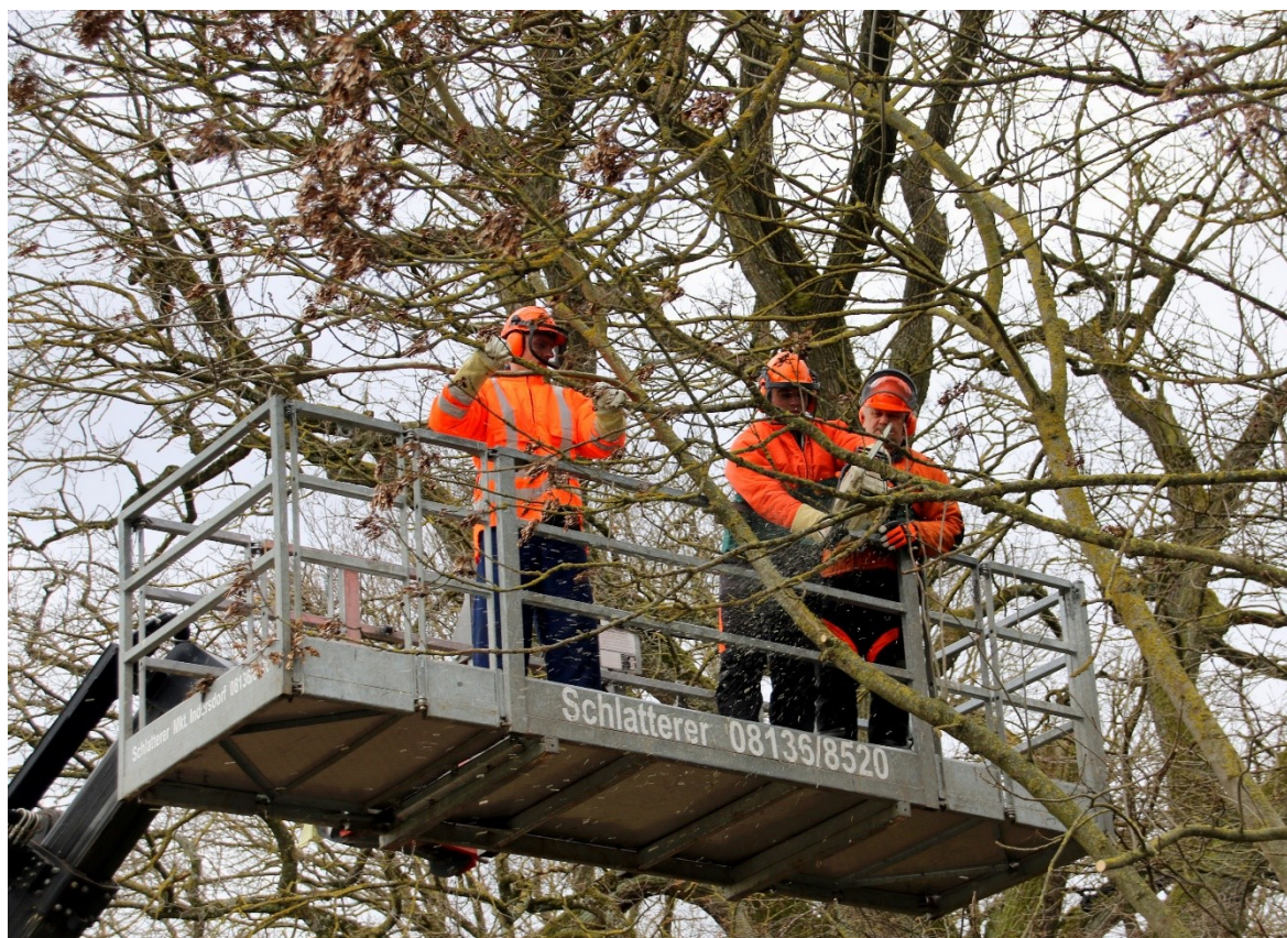
In einem Waldstück wurde das Arbeiten mit der Motorsäge im Korb geübt – 16.03.2019
