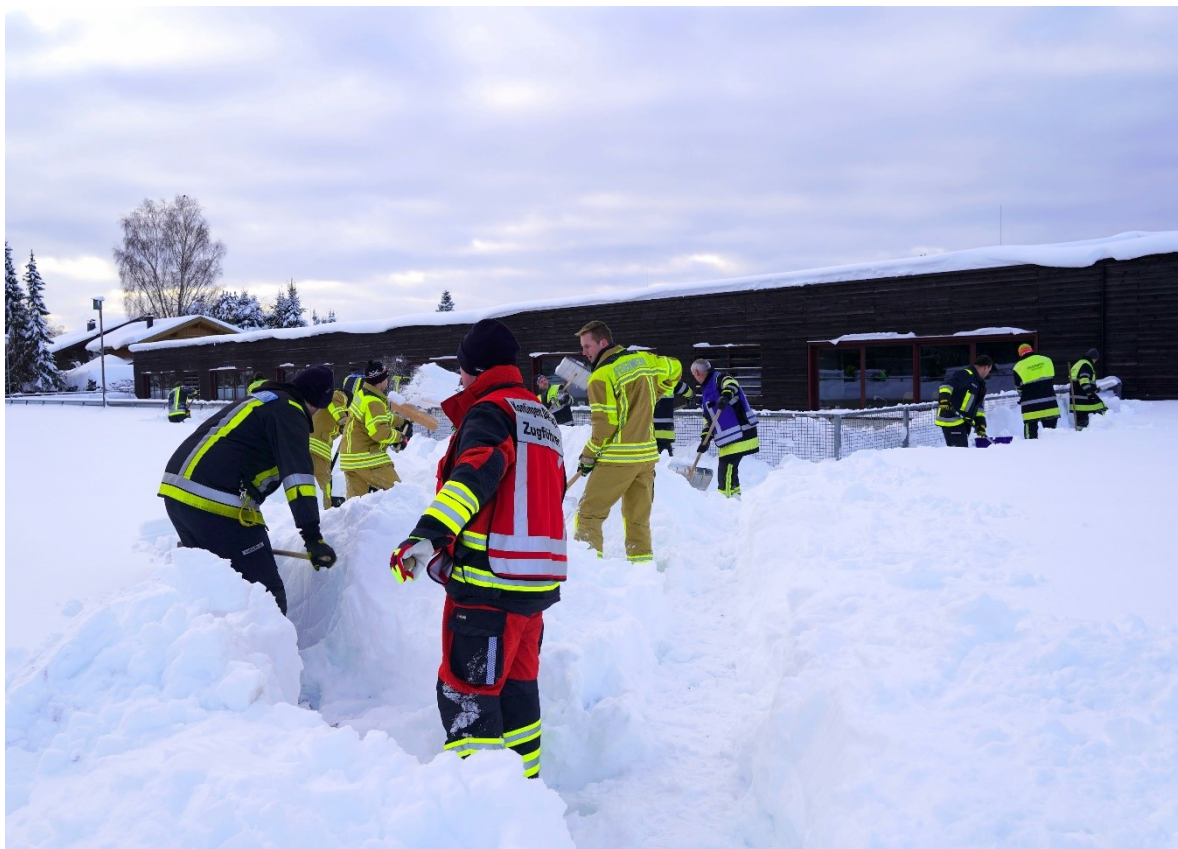
Das Dach der Oberland-Realschule in Holzkirchen wurde vom Schnee befreit – 11.01.2019
