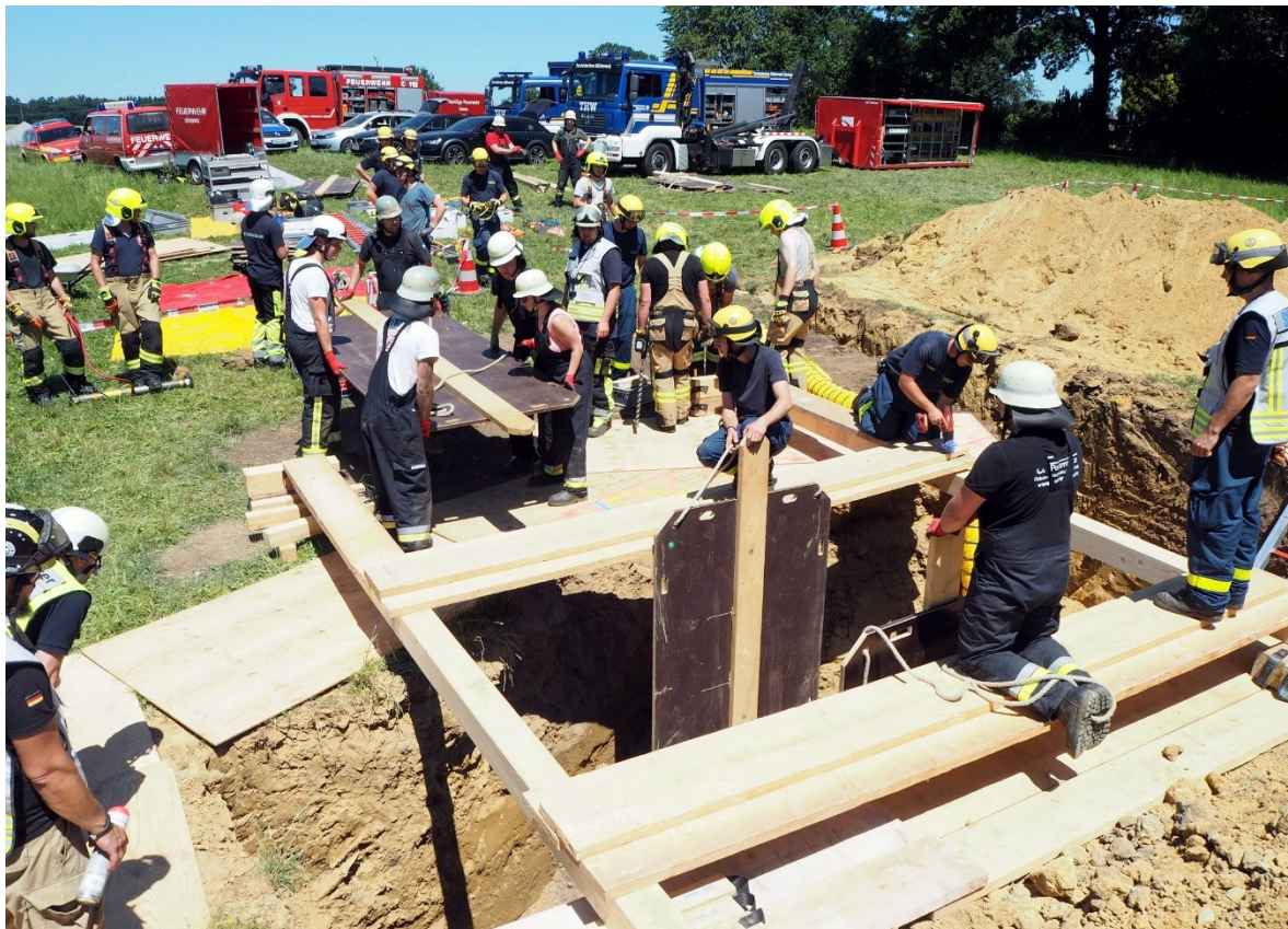
Praktische Ausbildung beim Tiefbaulehrgang in Günding – 29.06.2019
