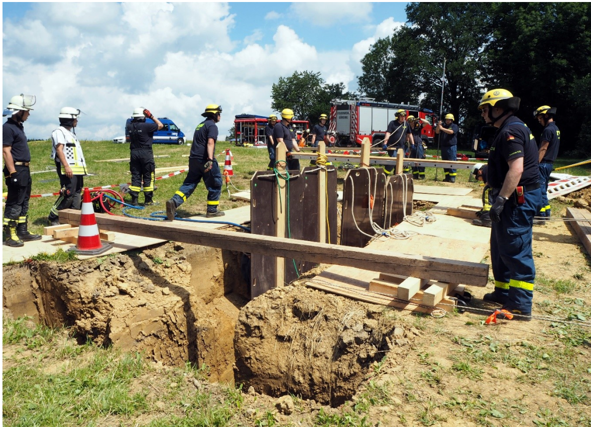
Praktische Ausbildung beim Tiefbaulehrgang in Günding – 02.06.2018
