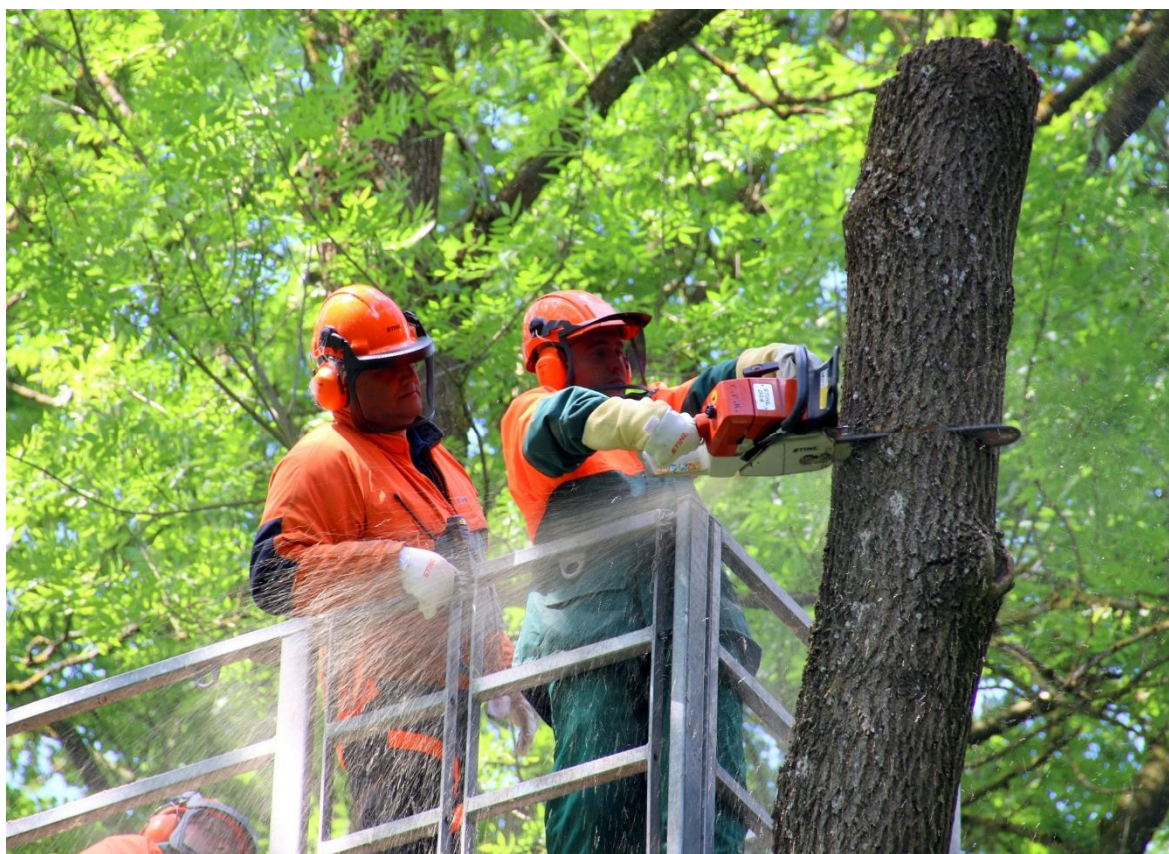
In einem Waldstück wurde das Arbeiten mit der Motorsäge im Korb geübt – 10.06.2017
