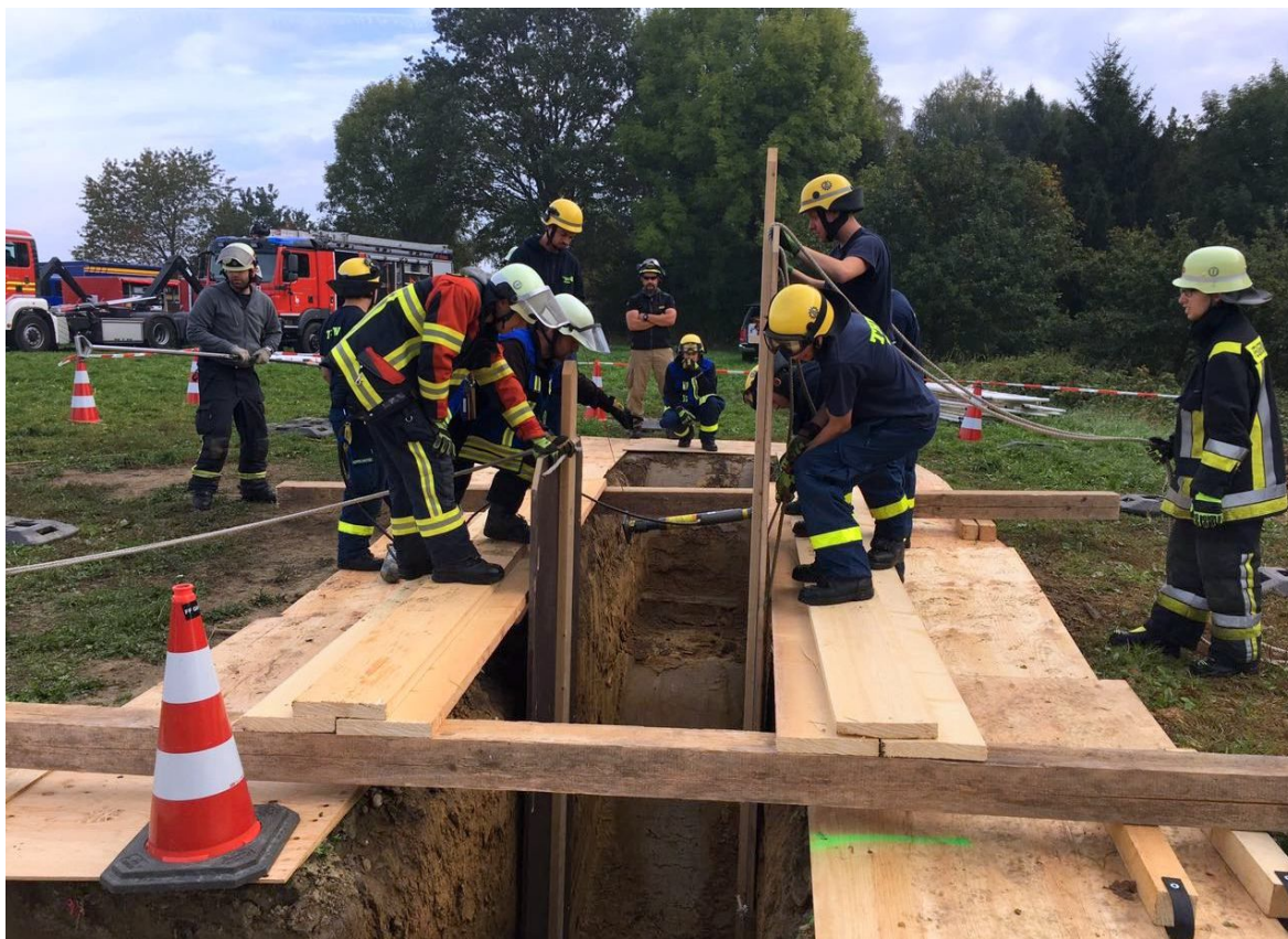
Praktische Ausbildung beim Tiefbaulehrgang in Günding – 30.09.2017
