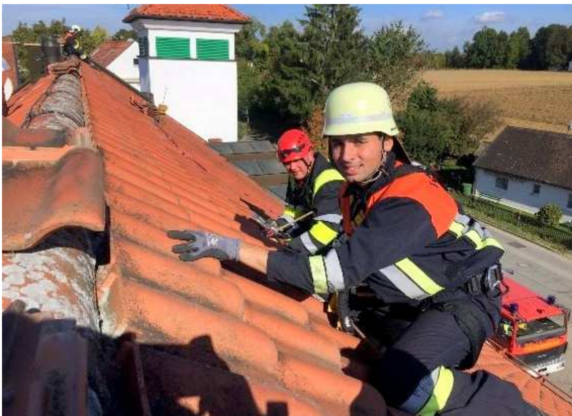
Praktische Übung auf dem Dach beim Grundkurs Absturzsicherung in Vierkirchen – 15.10.2016
