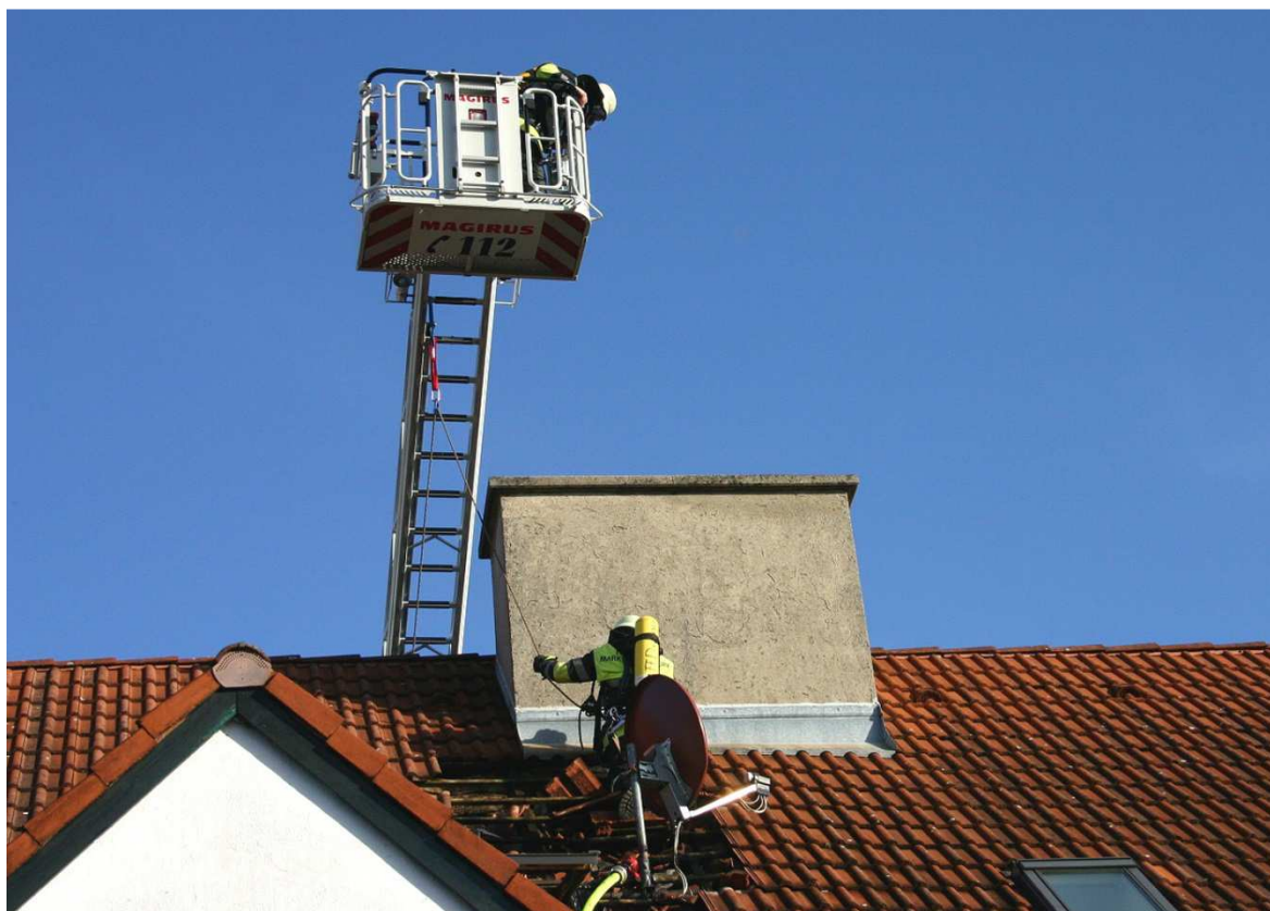
Einsatz des Gerätesatz Absturzsicherung nach einem Dachstuhlbrand in Weichs – 01.11.2014
