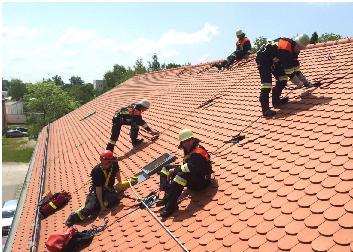
Ausbildung Absturzsicherung bei der Feuerwehr Dachau – 24.05.2014
