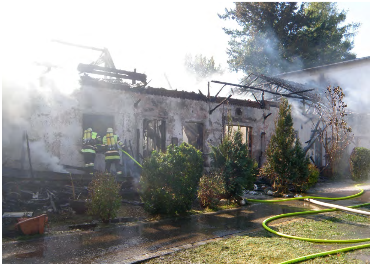
Ein Wohnhaus in der Dachauer Mittermayerstr. wird zum Raub der Flammen – 06.09.2013
