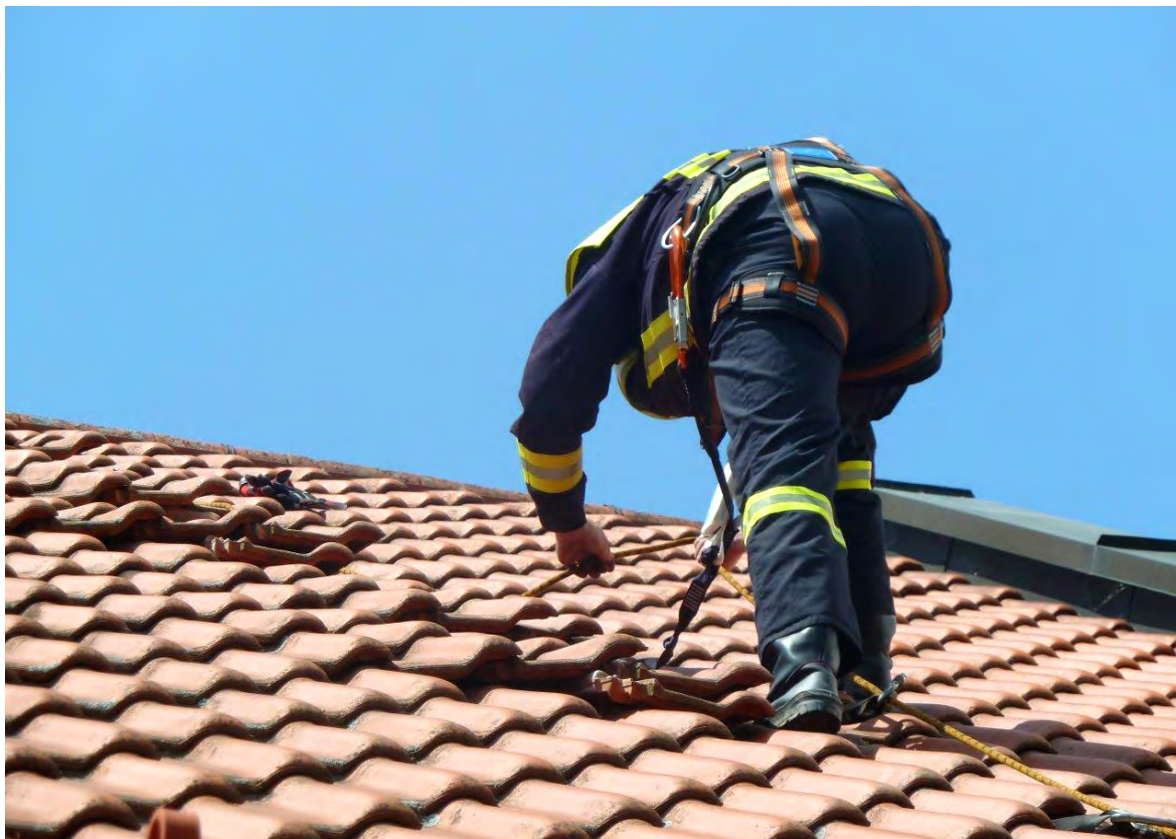
Ausbildung Absturzsicherung bei der Feuerwehr Vierkirchen – 20.07.2013
