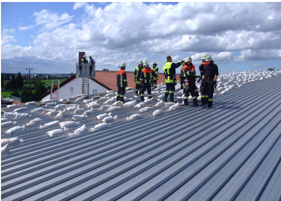
Mit Sandsäcken musste das Dach der Mehrzweckhalle Vierkirchen gegen den Sturm gesichert werden – 11.06.2009
