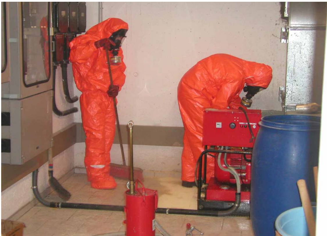
Auslaufende Batteriesäure wird von Kräften der Feuerwehr Dachau unter leichtem Chemikalienschutzanzug gebunden – 12.07.2009
