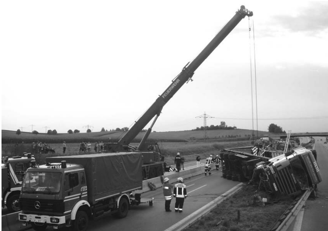
Am 21.08.2007 übersah ein LKW-Fahrer die Fahrbahnverengung im Baustellenbereich der A 8, so dass sein LKW umstürzte und vom Kran der BF München aufgerichtet werden musste
