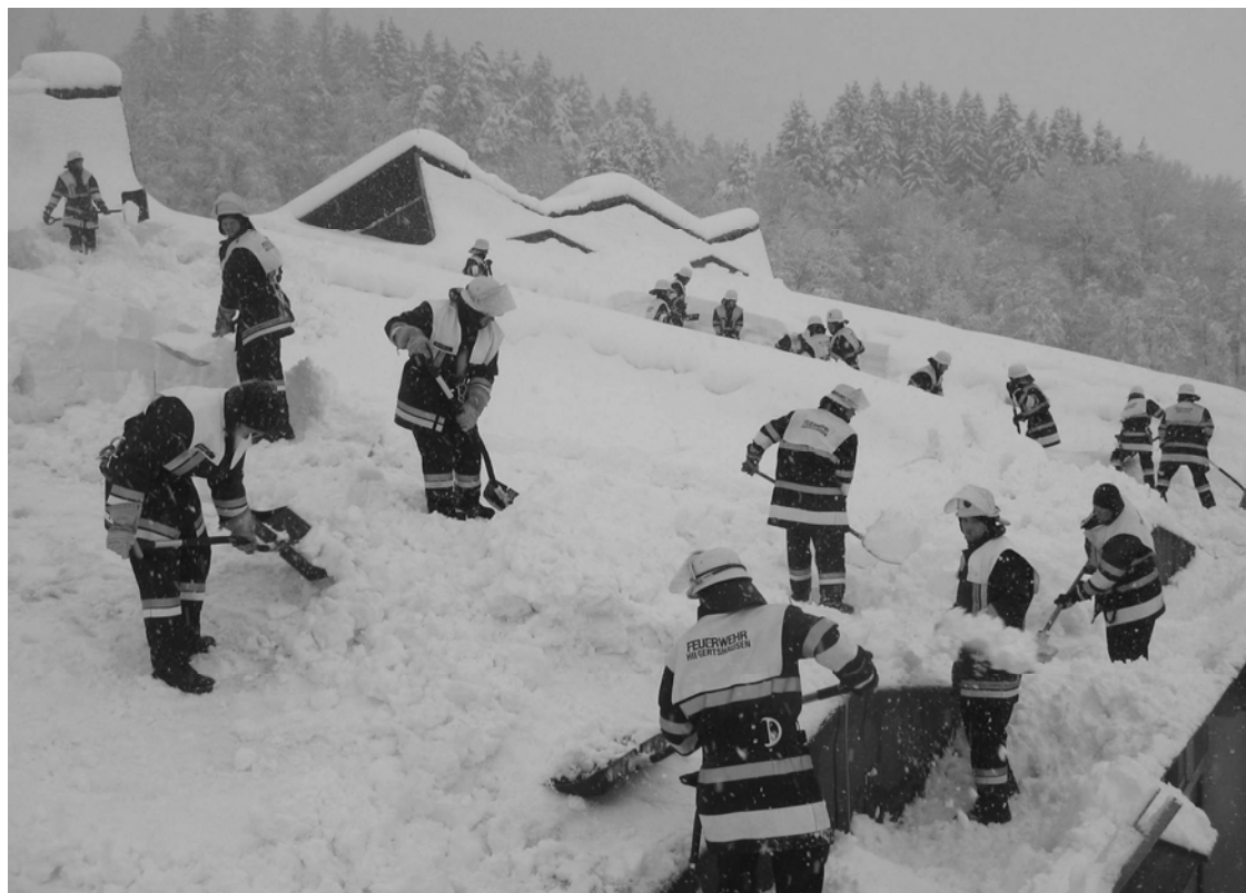
Feuerwehrkräfte aus dem Landkreis Dachau befreien das Dach der Eissporthalle in Degendorf von Schneemassen
